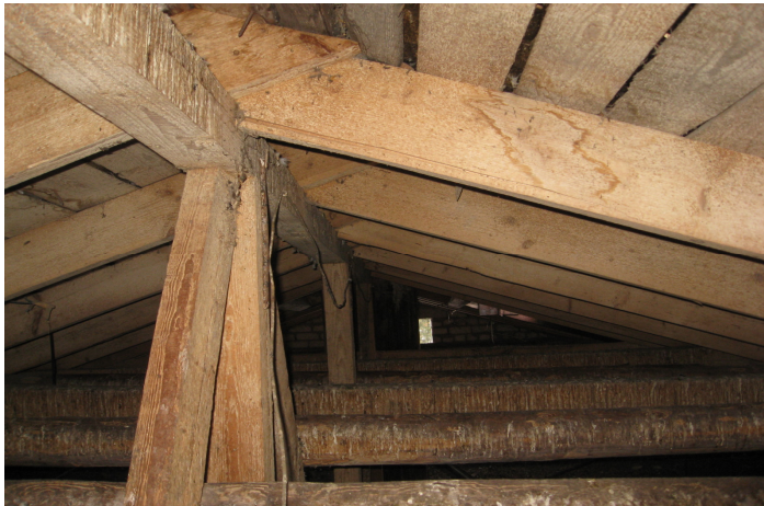
F-2. Jumta konstrukcijas kopumā apmierinošas. Bojājumi atsevišķās vietās, lielākajā daļā redzamas mitruma pēdas.
