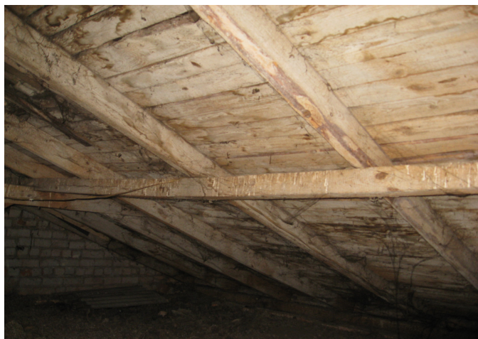
F-4. Spāres to vidusdaļā balstās uz 10x10cm šķēluma garensijas. Sijai liela izliece, kas rada arī spāru nevienmērīgu izlieci, atkarībā no balsta vietas. Lielāks konstrukciju un latojuma nolietojums tuvāk jumta malai, kas liecina par nepietiekamu vēdināšanos šajās zonās.
