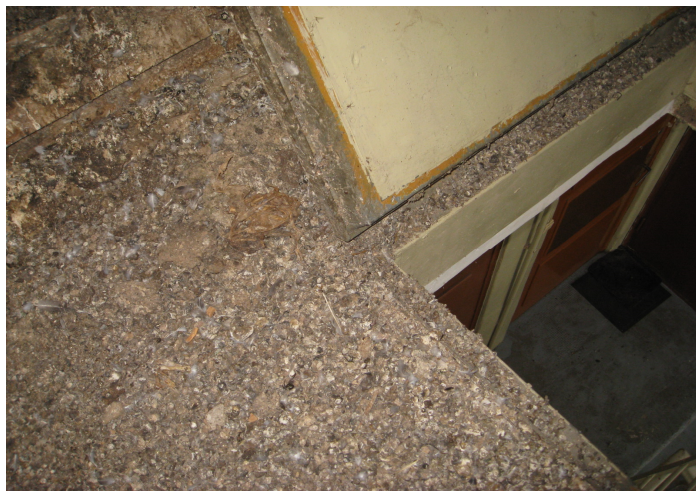
F-6. Bēniņu lūka smaga, sliktas eņģes. Siltinājums nav norobežots no atveres, lūku lietojot tas birst kāpņu telpā un apgrūtina lūkas aizvēršanu.
