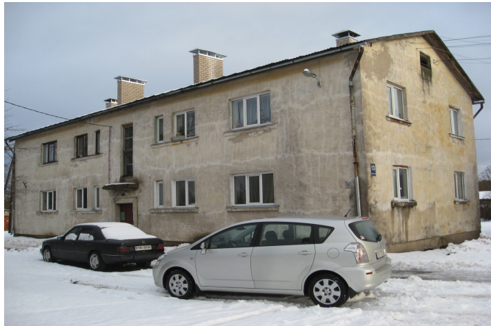
F-1. Kopskats uz ēku no ieejas puses. Nolietojušās jumta malas, to koka detaļas. Daļēji remontēta ūdens novadīšanas sistēma. Jauns skursteņu mūrējums virs jumta un pieslēgumi. Viļņotais onduline segums. Gala aillas ar bojātu aizpildījumu.
