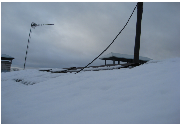
F-5. Seguma loksnes slikti pieguļ dēļu klājam un viena otrai. Riskantas antenu izvadu vietas. Pilnībā bojāta kores detaļa. Labā stāvoklī jumtiņš skurstenim.
