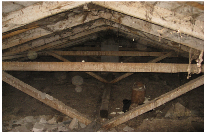
F-2. Jumta koka konstrukcija ievērojami nolietojusies. Slīpie balsti, mūrlatas un savilces saglabājamās, pārbaudāmi visi mezgli. Spāres maināmas. Pilnais dēļu klājs un ruberoida paliekas demontējamas.
