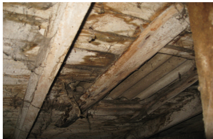
F-3. Bojāts, samircis latojums. Iespējams, bijis caurules izvads, izmantots šīferis.
