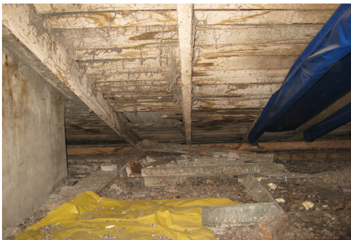
F-3. Vietām konstrukcija remontējama. Stipri bojāts dēļu klājs zem jumta ieseguma. Nevienāds, bojāts un sablīvēts pārseguma pakojums.
