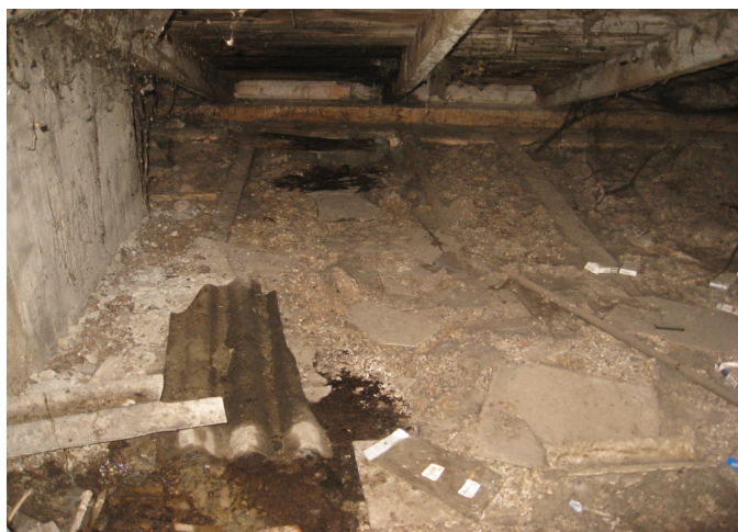
F-5. Bēniņos dažādi būvniecības atlikumi. Mitrums uz grīdas un siltinājuma, kas sablīvējies. Jumta malā spāru gali un latojums sapuvuši.
