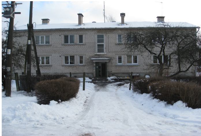
F-1. Kopskats uz galveno ēkas fasādi. Šīfera jumta plaknei daudzviet bojājumi, ieliekumi skursteņu tuvumā. Notekas un skursteņi labā stāvoklī. Bojātā jumta seguma un siltuma zudumu dēļ augšdaļā mitrinās fasāde.
