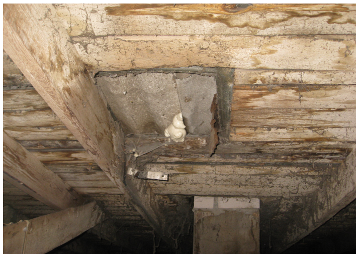
F-4. Juntam bijušas vairākas lūkas, kas aizbūvētas. Visas lūkas un to pieslēgumu vietas segumam pilnībā bojātas. Stipras mitruma pēdas uz dēļu klāja un spārēm. Piemūrētas skursteņu augšas daļas.
